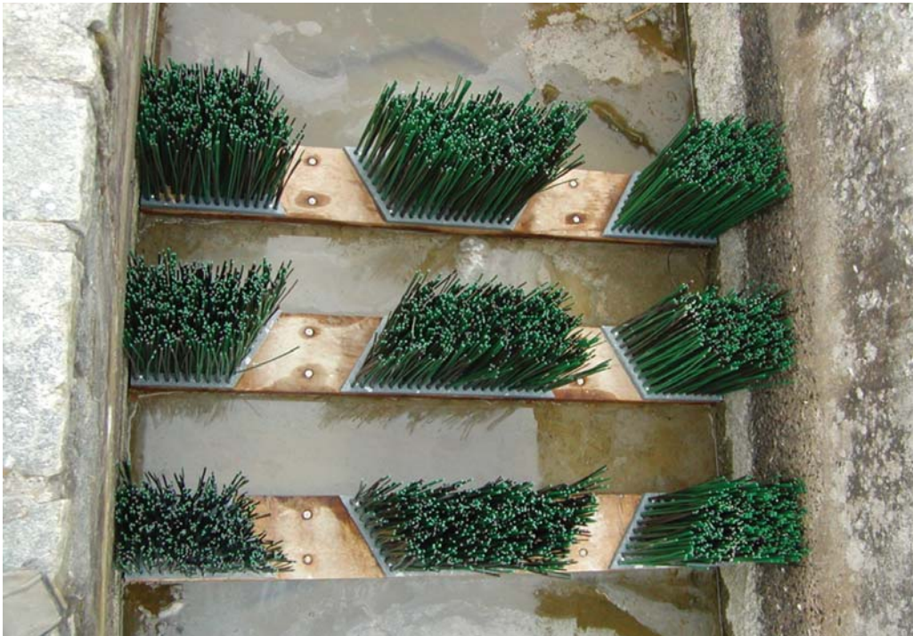
Obr. 3.8.10. Detail kartáčů štěrkové propusti na řece Sázavě (foto: J. Vait).
