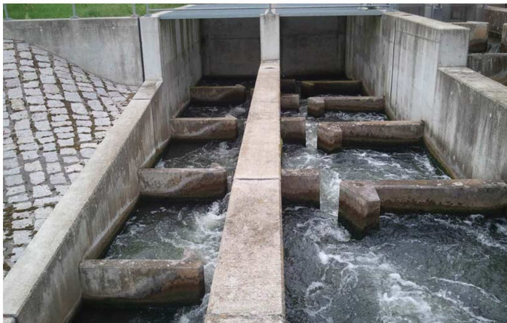
Obr. 3.8.4. Detail rozložení hlavních proudnic v komůrkách štěrbinového typu rybiho přechodu (VD Ladenburg, ř. Neckar, SRN, Foto: M. Drahoňovský)
