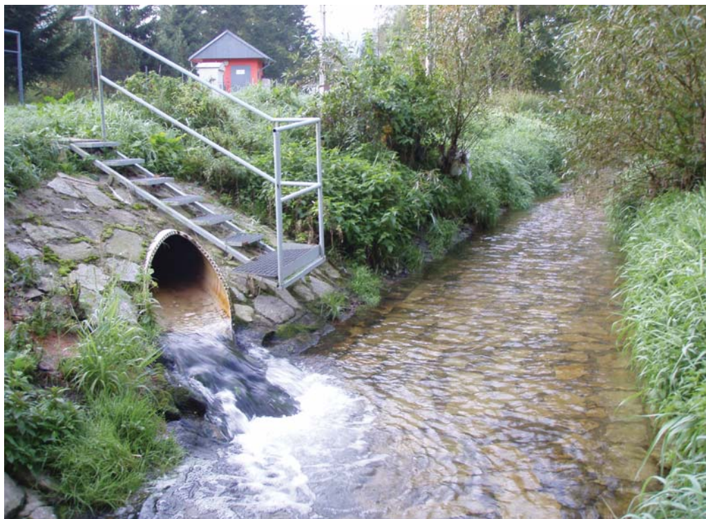
Obr. 5.5.8. Zaústění vyčištěných komunálních odpadních vod z ČOV Prachatice do Živného potoka. Tyto vody tvoří přibližně 30 % průtoku recipientu. U ryb vyskytujících se pod touto ČOV dochází k poruchám reprodukce a dalším významným fyziologickým změnám v organismu (foto: T. Randák).
