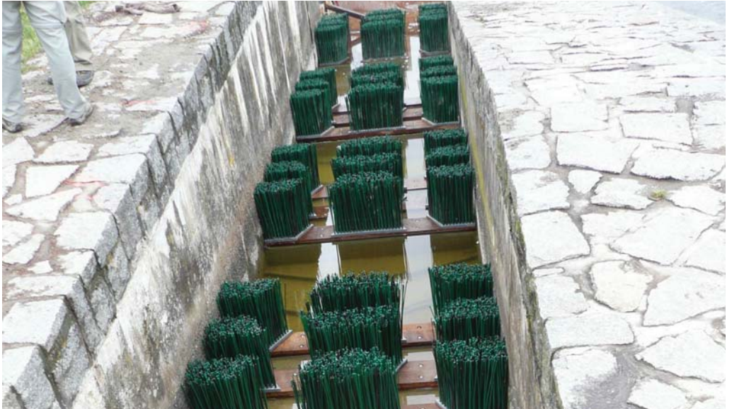
Obr. 3.8.9. Kartáčový pokryv dna (Hassinger, 2002) štěrkové propusti (jez Budín, ř. Sázava, ČR, foto: J. Vait).
