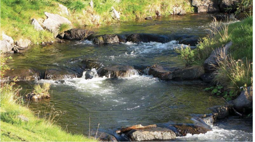
Obr. 3.8.2. Příklad obtokového kanálu balvanitého rybiho přechodu v celkovém pohledu – detail (VD Obermaubach, ř. Rur, SRN, foto: M. Drahoňovský).
