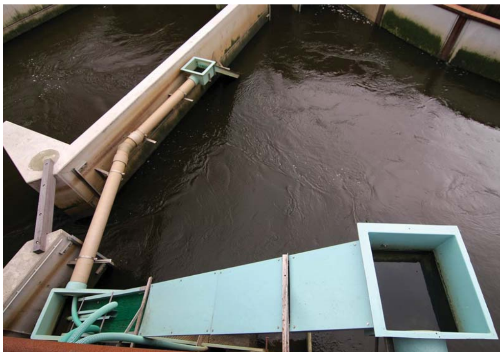
Obr. 3.8.8. Speciální konstrukce pro migraci juvenilních úhořů II (VD Geestacht, ř. Labe, SRN, foto: M. Drahoňovský).
