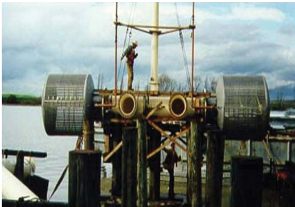
Obr. 5.3.4. Cylindrický válec z lichoběžníkových prutů instalovaný jako ochranný filtr na potrubí odebírající technologickou vodu (foto převzato z http://www.bdiscreens.com/fishdiversion.htm se souhlasem Industrial Screen Products, Inc., P.O. Box. 366, Placerville, CA 95667 USA).
