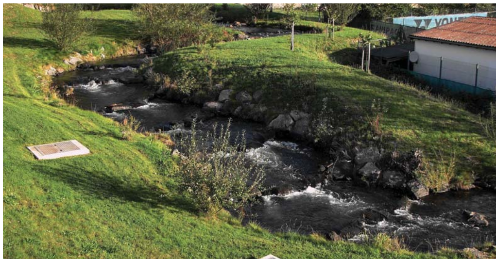
Obr. 3.8.1. Příklad obtokového kanálu balvanitého rybího přechodu v celkovém pohledu (VD Obermaubach, ř. Rur, SRN, foto: D. Bůžek).
