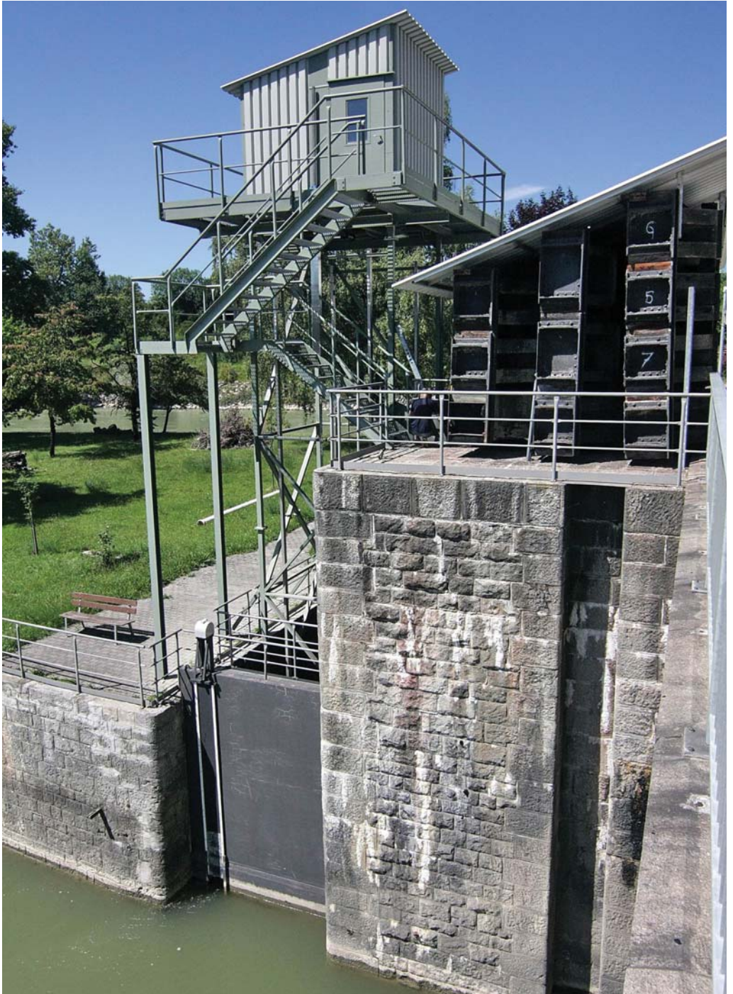
Obr. 3.8.6. Zdvíž umožňující migrace ryb přes překážku. Tato druhově selektivní zařízení zajistí migraci nedostatečně – pouze v určitých intervalech (VD Wyhlen, ř. Rýn, SRN, foto: M. Drahoňovský).
