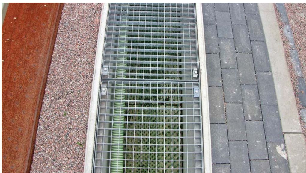
Obr. 3.8.7. Speciální konstrukce pro migraci juvenilních úhořů I (VD Geestacht, ř. Labe, SRN, foto: D. Bůžek).
