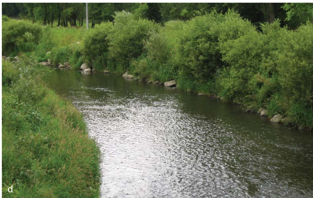
Obr. 5.1.8. Různé typy podélných regulací toků (a – zatrubnění – Bílina pod Jirkovem, b – tvrdé opevnění – Bílina, Jirkov, c – kamenné opevnění břehů – Bílina nad Mostem, d – opevnění nárazového břehu – Vlára, Bylnice; foto: Z. Adámek).
