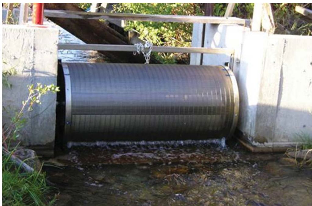
Obr. 5.3.8. Rotační sítěný válec. (foto převzato z http://www.bdisccreens.com/fishdiversion.htm se souhlasem B. Deo-Volente, Inc. 1255 Monmouth Blvd., Galesburg, Illinois 61401).
