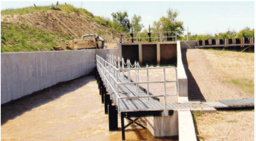
Obr. 5.3.6. Pohled proti proudu zavlažovacího kanálu – šikmé postavení zábrany – Louver. (foto převzato z http://www.usbr.gov/pmts/hydraulics_lab/pubs/manuals/fishprotection/ se souhlasem U.S. Department of the Interior Bureau of Reclamation Denver, Colorado 2006: Fish Protection at Water Diversions, A Guide for Planning and Designing Fish Exclusion Facilities 2006, pp. 480).
