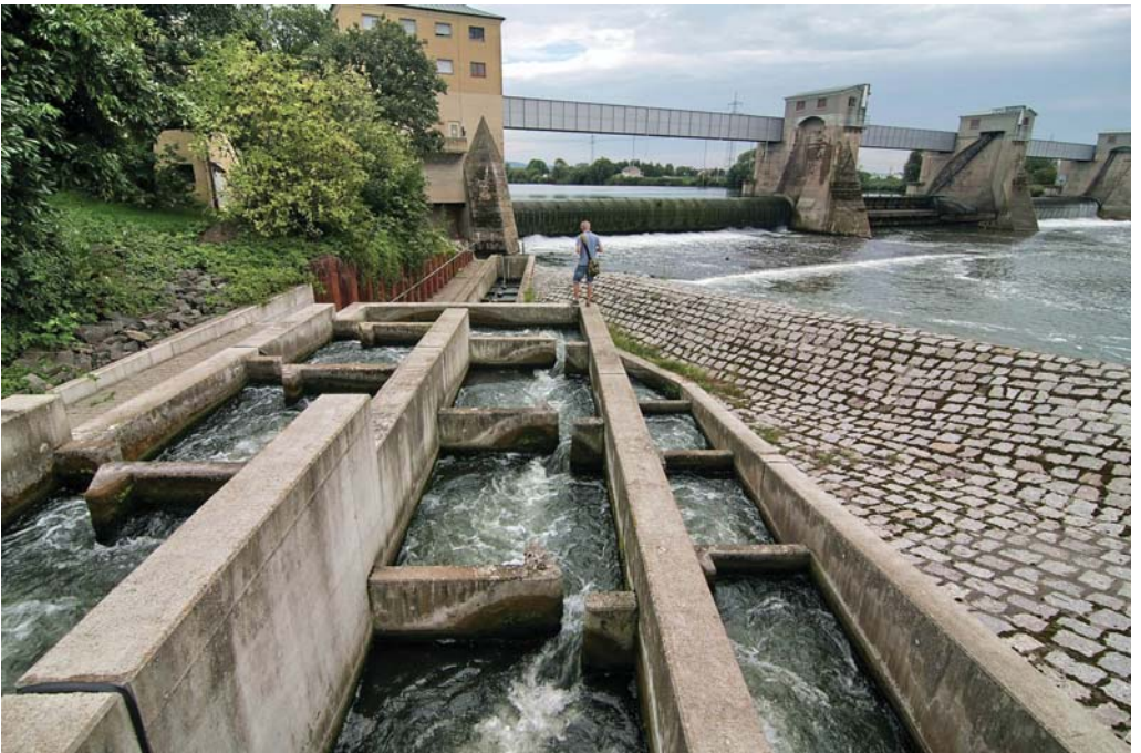
Obr. 3.8.3. Štěrbínový typ rybiho přechodu (VD Ladenburg, ř. Neckar, SRN, foto: M. Drahoňovský).
