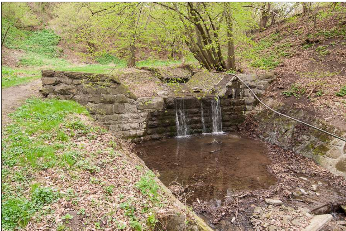
Obrázek 28 Horní úsek toku ve svažitém terénu s tvrdým kamenným zpevněním dna i břehů včetně příčných stupňů pro zpomalení odtoku. Moravanský potok – severní Čechy. (foto M. Petrtýl)
